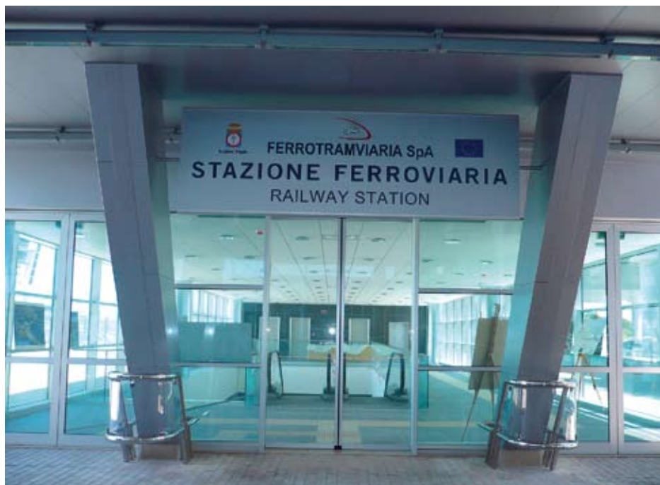
Collegamento Bari Centrale - Aeroporto "Karol Wójtyla". Ingresso Fabbricato "Transito Passeggeri"
