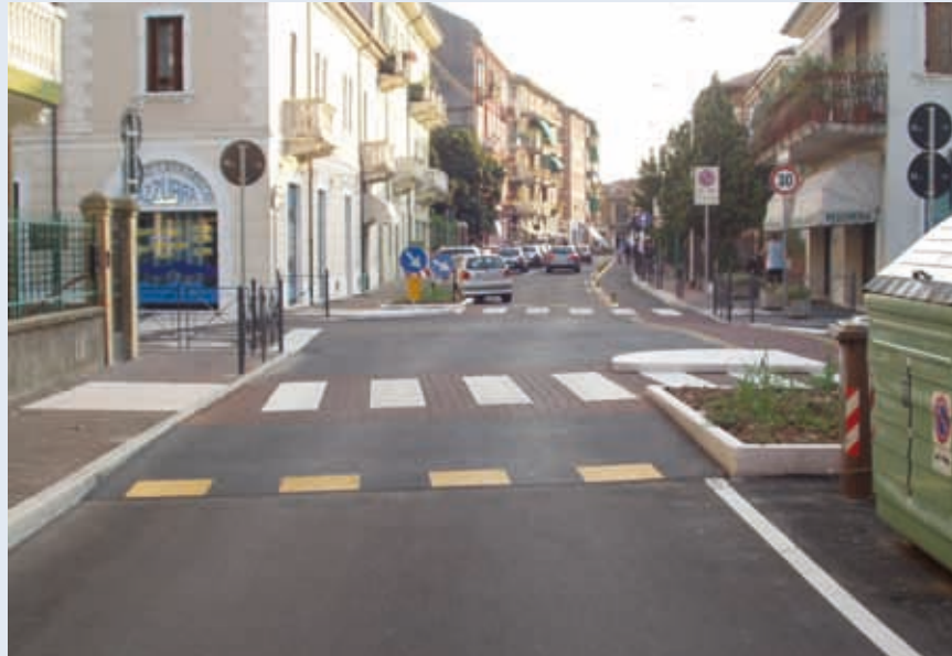
VERONA, CHICANE REALIZZATA CON ALTERNANZA DELLA SOSTA E CONTESTUALE PIATTAFORMA RIALZATA IN BITUME
