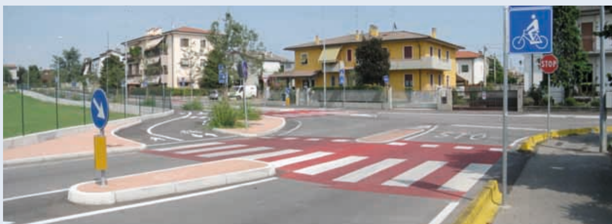
VILLAFRANCA DI VERONA - ATTRAVERSAMENTI AD ALTA VISIBILITÀ
