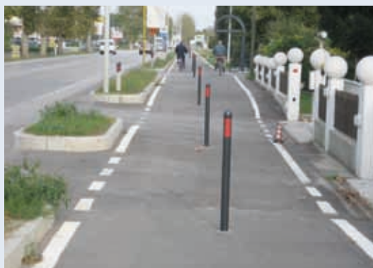
IN PROSSIMITÀ DEI PASSI CARRAI I PALETTI NON CONSENTONO AL CICLISTA DI EVITARE L'AUTO CHE ESCE
