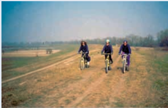
GLI ARGINI RICHIEDONO PAVIMENTAZIONI SCORREVOLI, STABILI E DRENANTI
