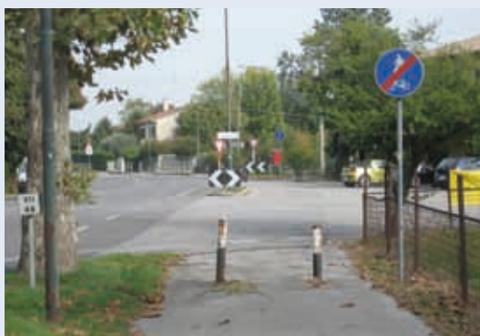
MANCA COMPLETAMENTE LA SEGNALETICA ORIZZONTALE
