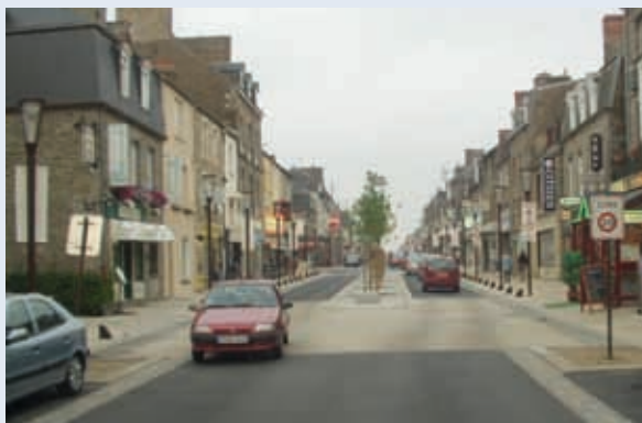
ZONA 30, CAMBIO DI PAVIMENTAZIONE E FASCIA CENTRALE ALBERATA
