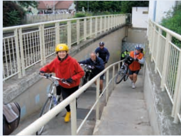
FRANCIA SOTTOPASSO FERROVIARIO URBANO
