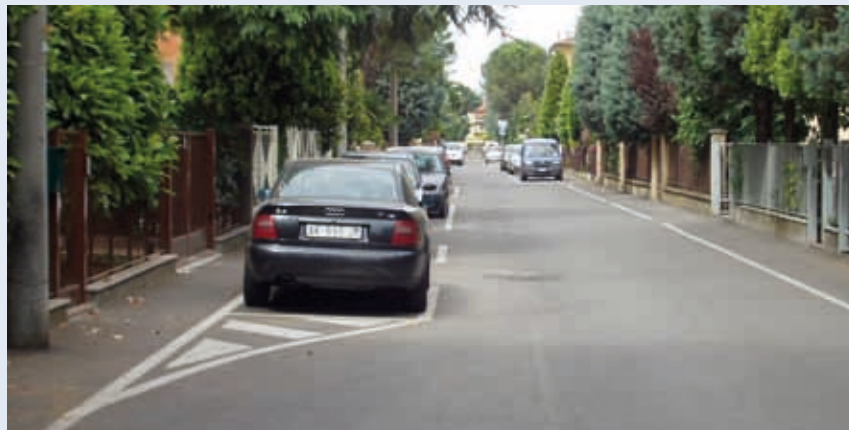
IMOLA, MARCIAPIEDI REALIZZATI CON LA SEGNALETICA
