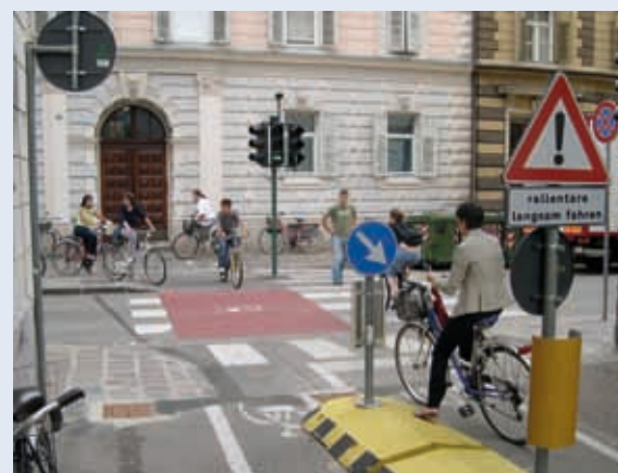
IN QUESTE SITUAZIONI DIVENTEREBBE IMPORTANTE DEDICARE UN TEMPO SEMAFORICO SPECIFICO ALLA PISTA CICLABILE
