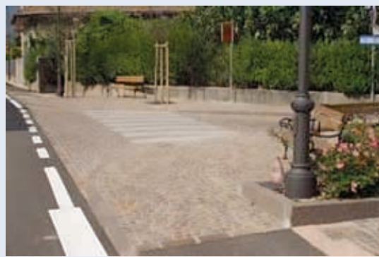
CONTINUITÀ DEL MARCIAPIEDE - MEZZOCORONA
