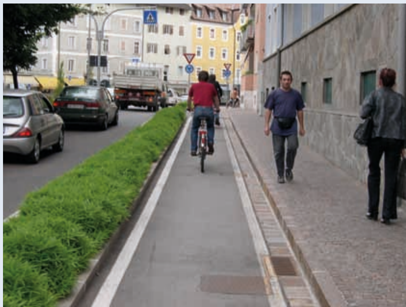
MONODIREZIONALE A QUOTA STRADA IN SEDE PROPRIA SITUAZIONE OTTIMALE, C'È LA LINEA DI MARGINE E LA SIEPE È BASSA E NON OSTRUISCE LA VISUALE
