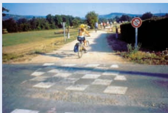
IN CORRISPONDENZA CON AL VIABILITÀ MINORE
