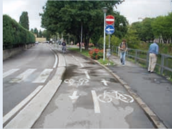
PADOVA (SEPARAZIONE CON SOPRAELEVAZIONE DEL PIANO DELLA CICLABILE E CORDOLO DA 50 CM.)
