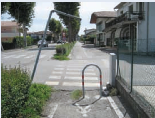
ESEMPIO DI MANUTENZIONE CARENTE
