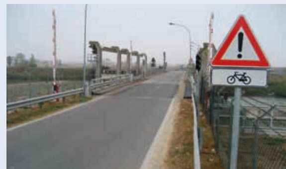
PARTICOLARE SEGNALETICA DI "ATTENZIONE"
