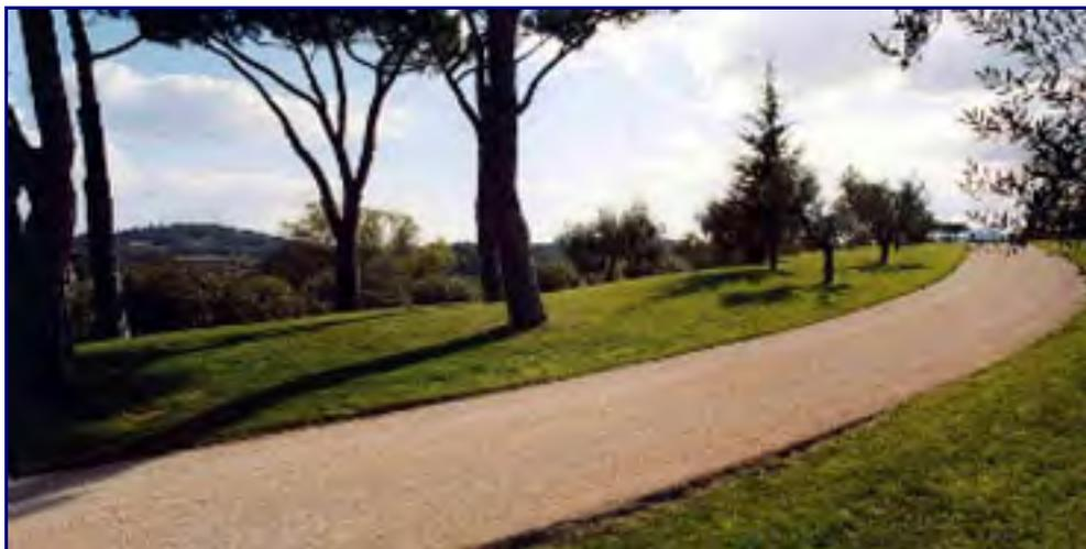
**Un esempio di pavimentazione in semipenetrazione**
