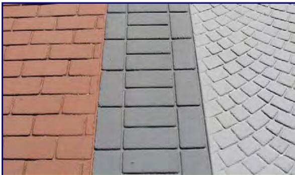
Asfalto stampato con imprimitura di disegni geometrici e resinatura in vari colori
